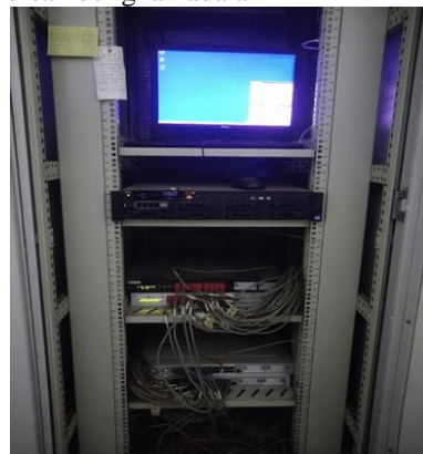
Gambar 14. Penyambungan Patch Panel atas ke Patch Panel bawah
