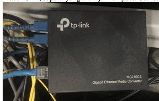
Gambar 15. Penyambungan Patch Panel bawah ke Media Converter
